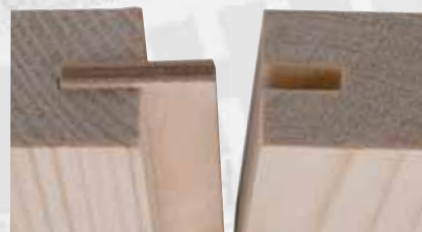
Photo 13 : l'assemblage à fausse-languette.
