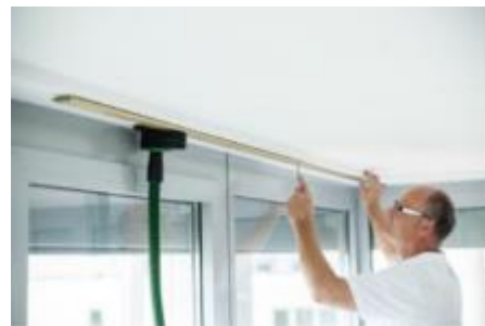
Installation d'un rail de rideau
