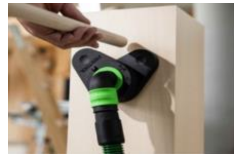
Fixation d'une tringle à vêtement ( mise à hauteur )
