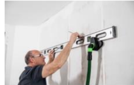
Maintien d'un niveau à bulle lors d'un traçage
