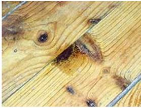
Il ne faut pas hésiter à appliquer le produit en couches fines et en plusieurs passes si les trous sont trop profonds.
