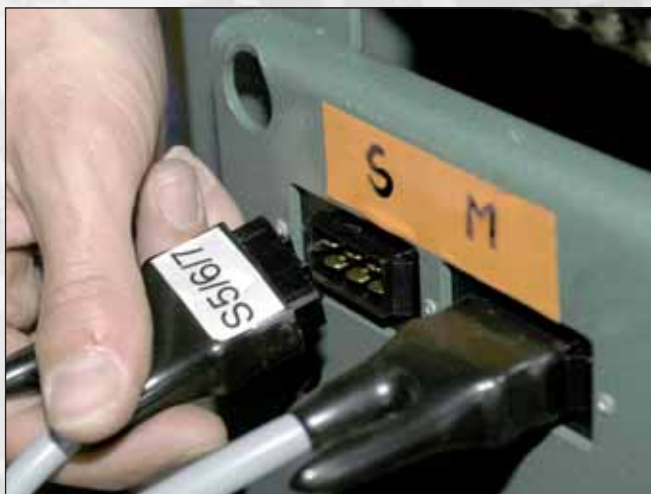
Vue n° 8 : Repérage des connexions électriques avant leur débranchement.
