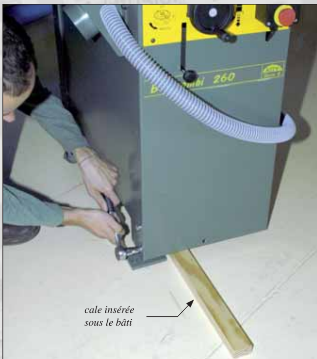
Vue n° 11 : Démontage des piétements métalliques.
