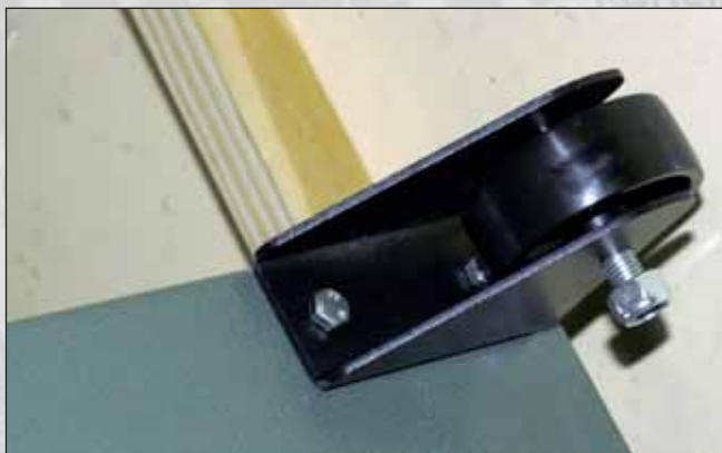
Vue n° 13 : Fixation des roues
