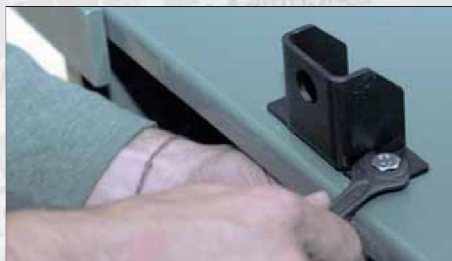
Vue n° 10 : Fixation du support du levier.
